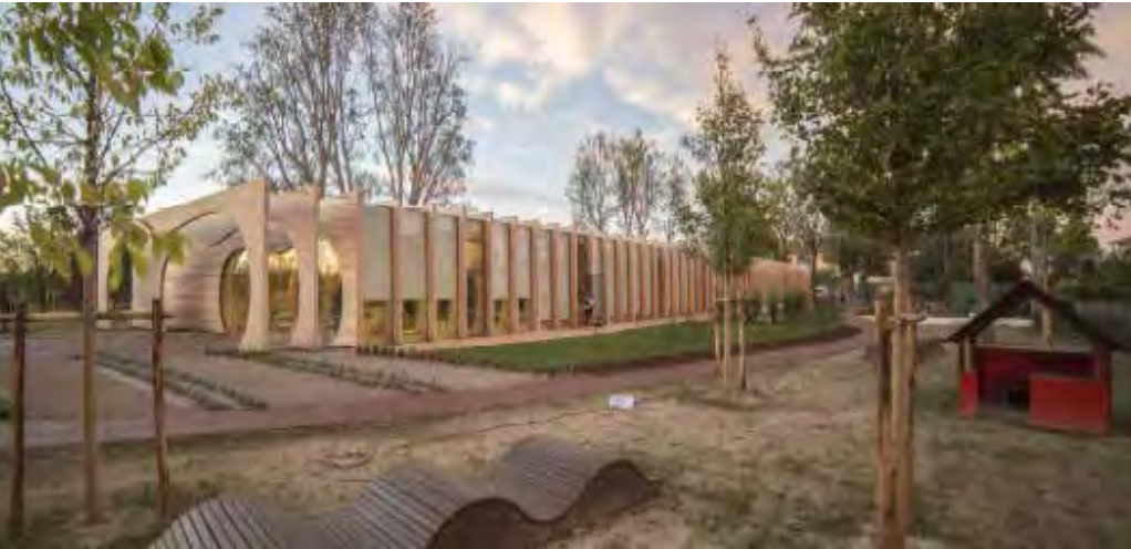
Scuola dell'infanzia, Guastalla (RE)
